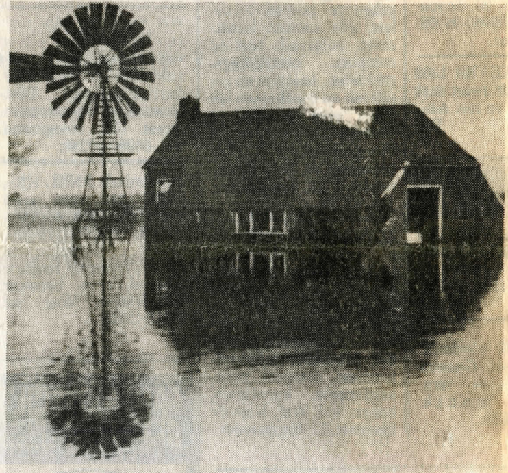
Harkstede. Het huis van de familie Bakker. Door de kracht van het water werd een deel van de muur weggeslagen.
