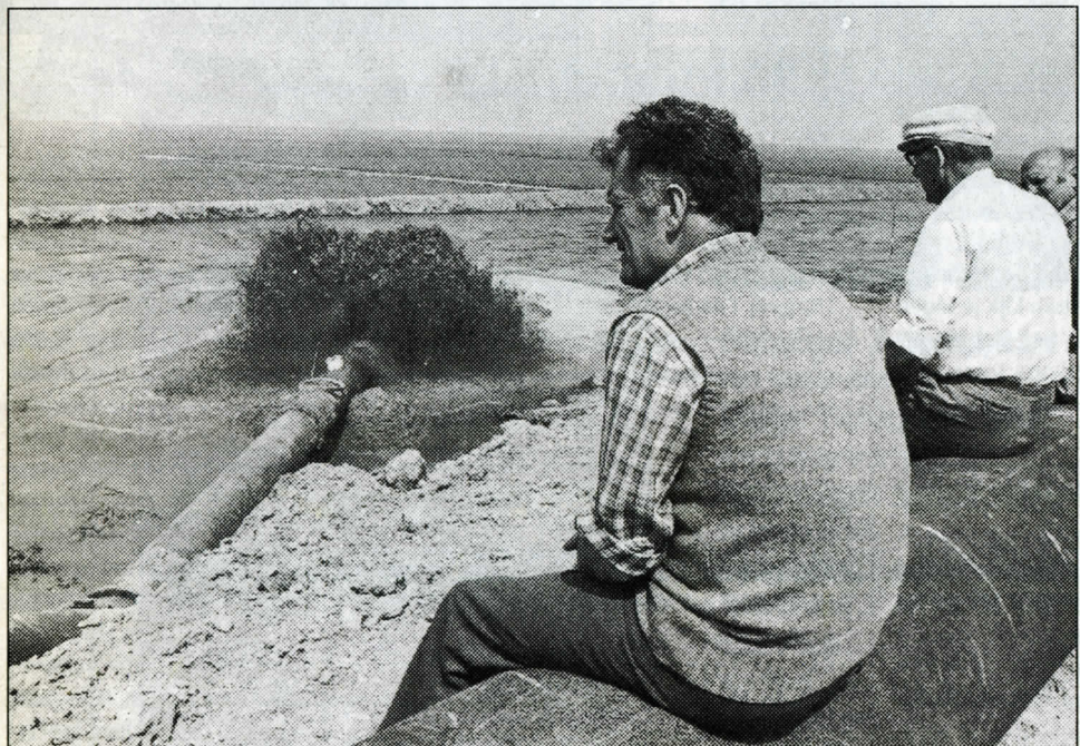
LAUWERSMEER - zomer 1981. De dijken moeten op deltahoogte worden gebracht. De werkzaamheden trokken veel bekijks.
