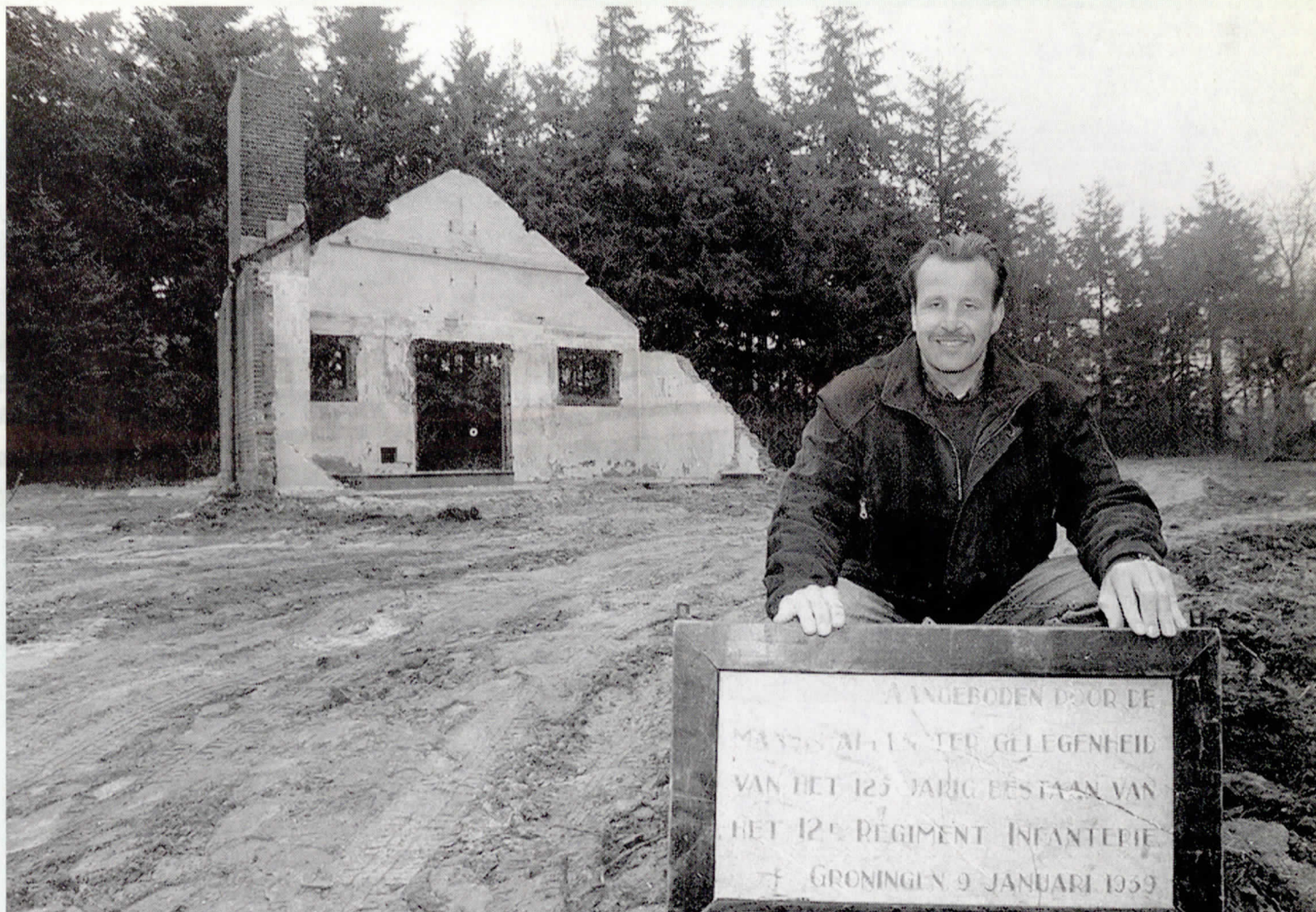
Spandau-uitvoerder Bert Turksema met de gedenkplaat. Op de achtergrond de voorgevel van het voormalige stafbureau plus schoorsteen die als herinnering aan de Rabenhaupt-kazerne blijven staan.
