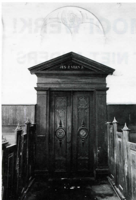
Binnenzijde van de toegangspartij tot de kerk van Wittewierum, vervaardigd in 1863: zorgvuldige houtbewerking en gietijzeren ornamenten, ook op de banken. Foto: Jan Hovinga, Zuidlaren.
