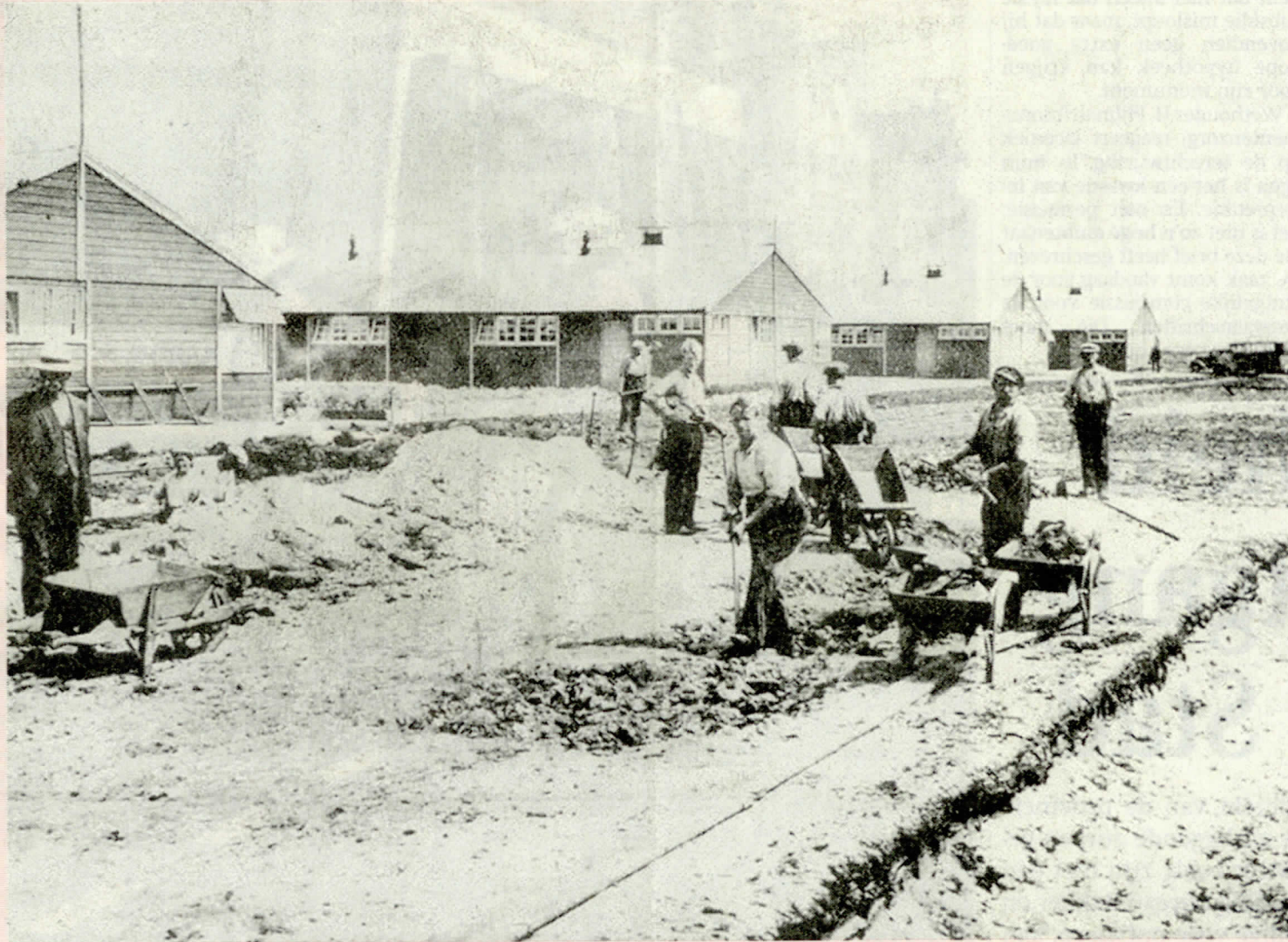
Met de aanleg van het - oorspronkelijke - werkkamp De Beetse werd in 1934 begonnen.
