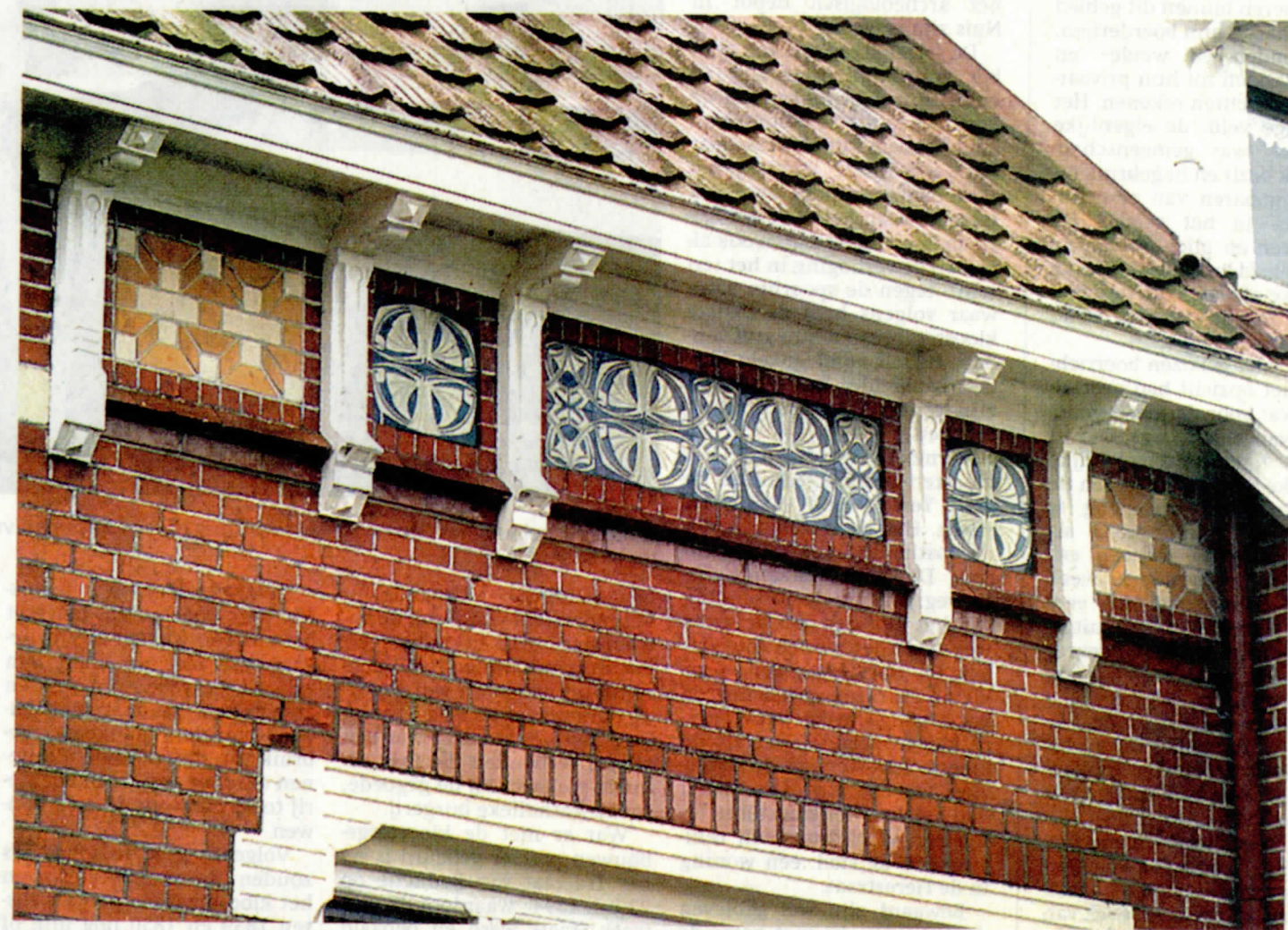
■ Onder de houten dakgoot van dit pand aan de Hoofdweg in Schildwolde zijn opvallende gevelstenen aangebracht.
